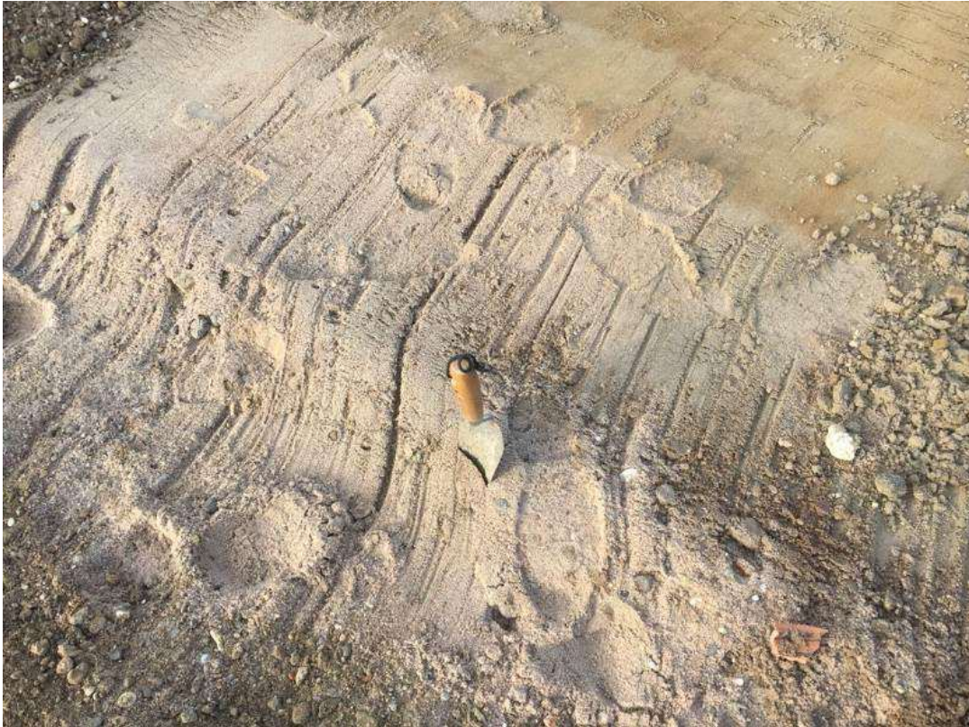
Abb. 2 Blick auf die geruchlich unauffällige Baugrubensohle.
